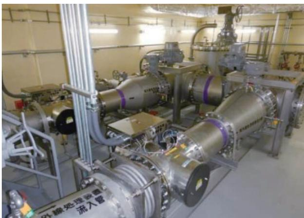
写真3 紫外線処理装置
